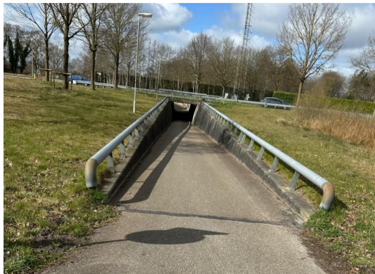
Figuur 7 Tunnel bij Foudenswei
